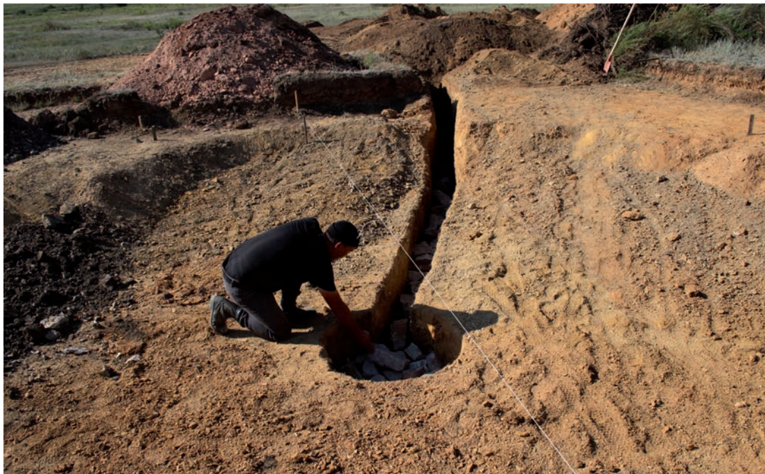
3-сур. Дренажды жүйені құру барысы. Сурет Ж.К. Сұлтанжановтікі Fig. 3. The process of creating a drainage system. Photo by Zh. Sultanzhanov Рис. 3. Процесс создания дренажной системы. Фото Ж.К. Сұлтанжанова
